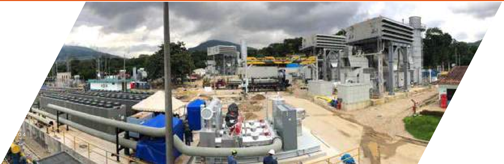
Ilustración 12 Instalación de nuevas unidades- Termoyopal
