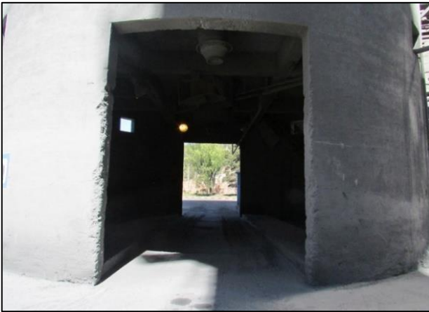
Fotografía 1 Silos de almacenamiento de cenizas volantes.
