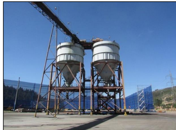
Fotografía 3. Almacenamiento de escorias
